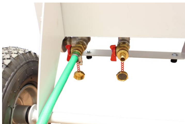
Abb. 9): Wasserzuleitung am KFE-Anschluss des Heizungs-rücklaufes der mobilen Elektroheizzentrale
